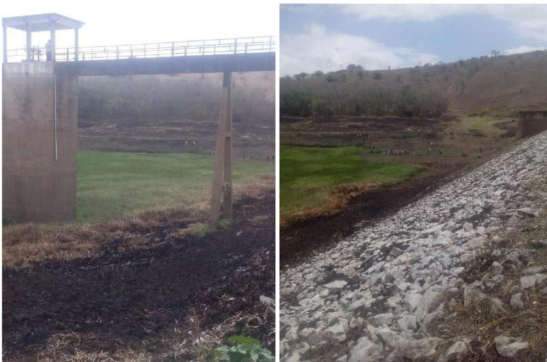
**Figuras 16 – Fotos da Seca – Talude de Montante.**
