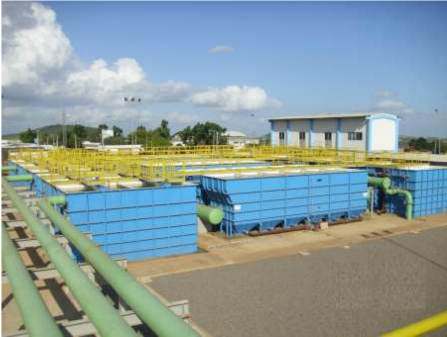
Figura 4 - Vista da nova ETA de Arapiraca
