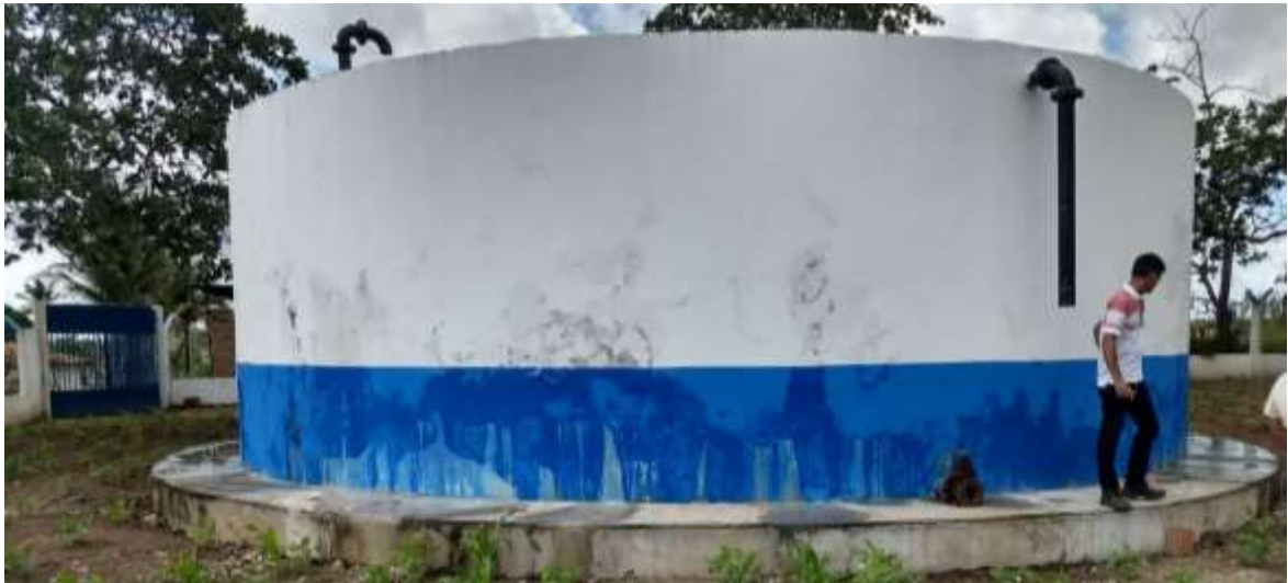
FOTO 2 – VAZAMENTO POR TODO PERÍMETRO DO RESERVATÓRIO.
