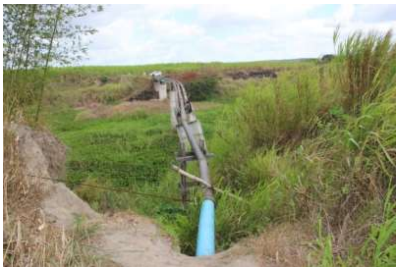
Figura 2 – Vista da margem esquerda da travessia do rio Paraíba
