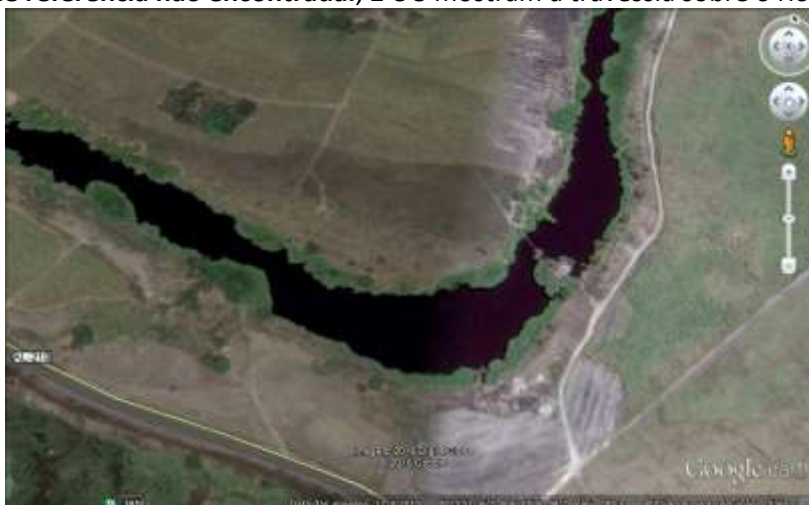
Figura 1 – Vista aérea da travessia
