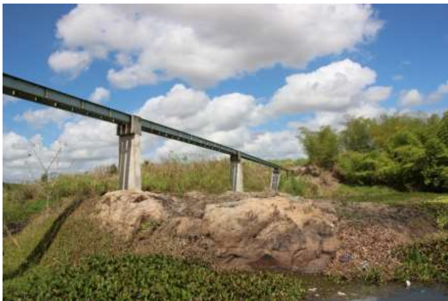
Vista da margem direita
