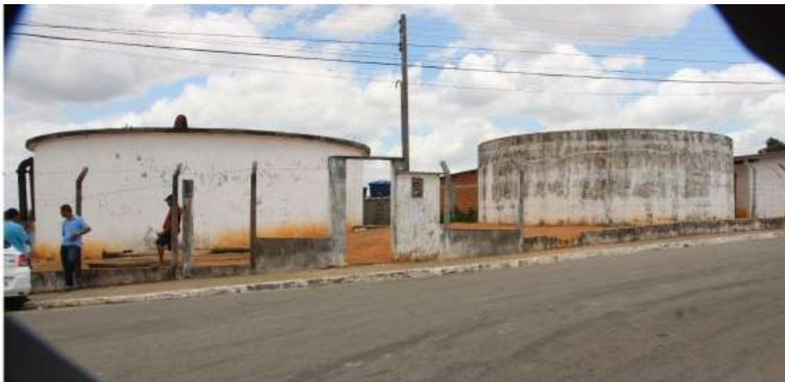
Figura 2. Vista dos reservatórios.
