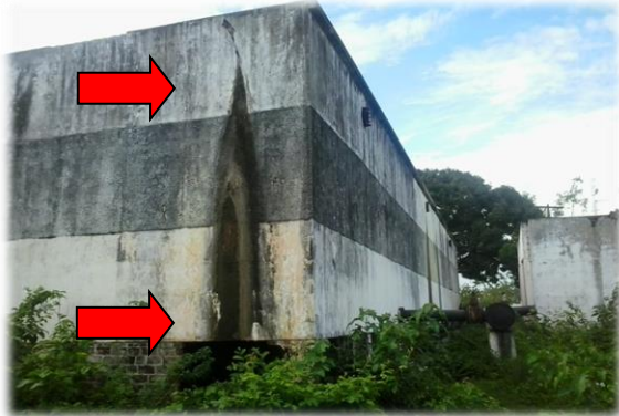
Figura 2 Percolação existente
