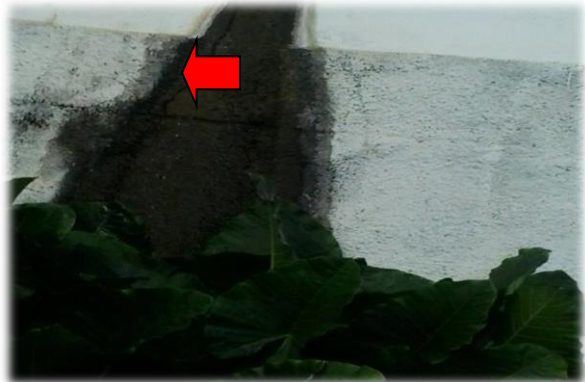
figura 3 Fissura existente
