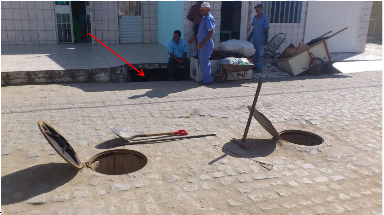
Foto 2. Rua Delmiro Gouveia: Galeria por onde passará o interceptor em ferro fundido.
