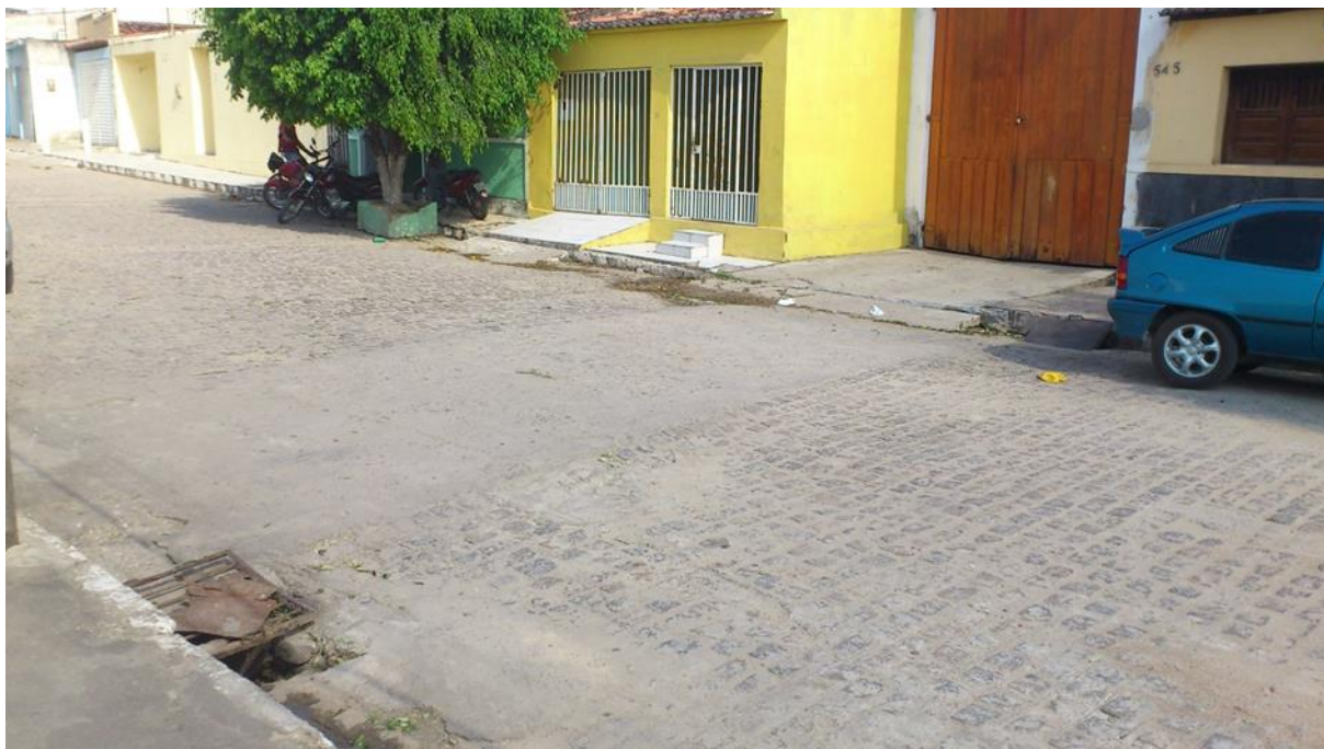
Foto 3. Rua Manoel Medeiros de Aquino: Galeria por onde passará o interceptor em ferro fundido.
