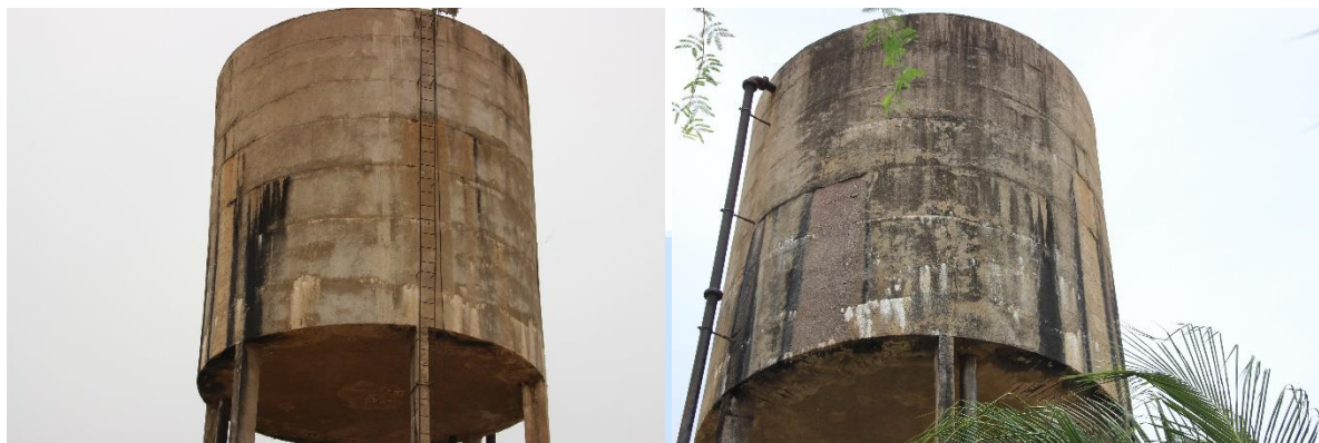
Figura 2. Vista do reservatório elevado
