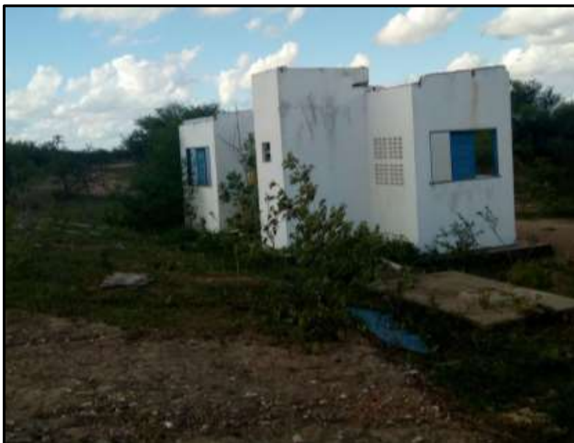
Imagem 02. Estação de Tratamento 02, da Cidade de Jaramataia
