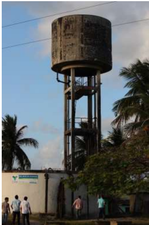
Figura 4. Vista do reservatório
