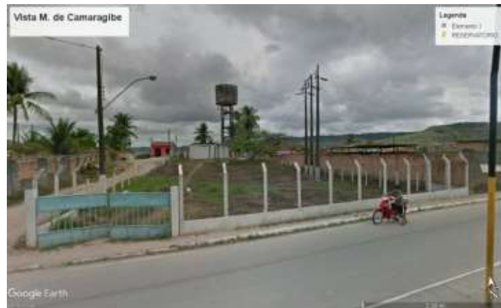
Figura 3. Vista da fachada
