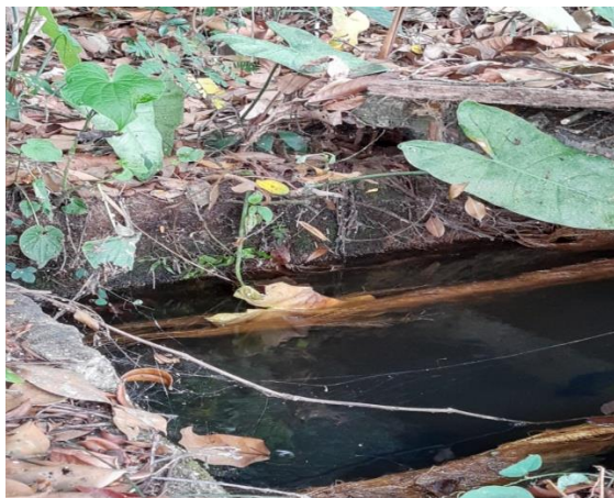
Aqueduto retangular Catolé – Cardoso: Placas danificadas e presença de raízes de plantas.
