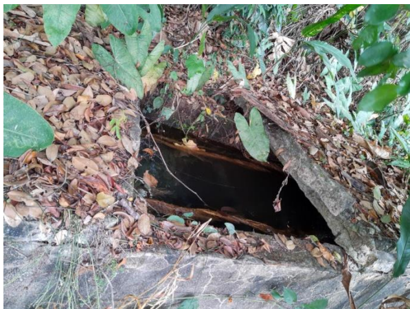
Aqueduto retangular Catolé – Cardoso: Placas danificadas e presença de raízes de plantas.
