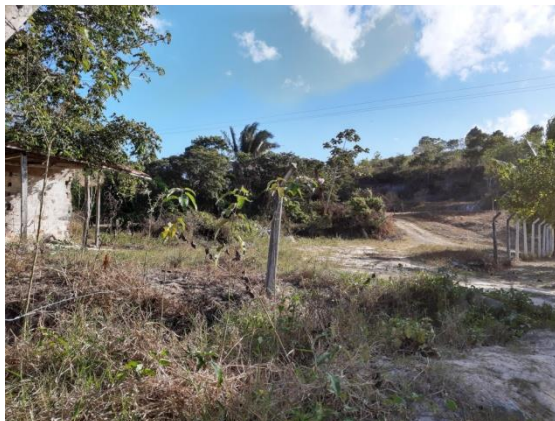
Entorno da Captação Pratagy: Cerca danificada.
