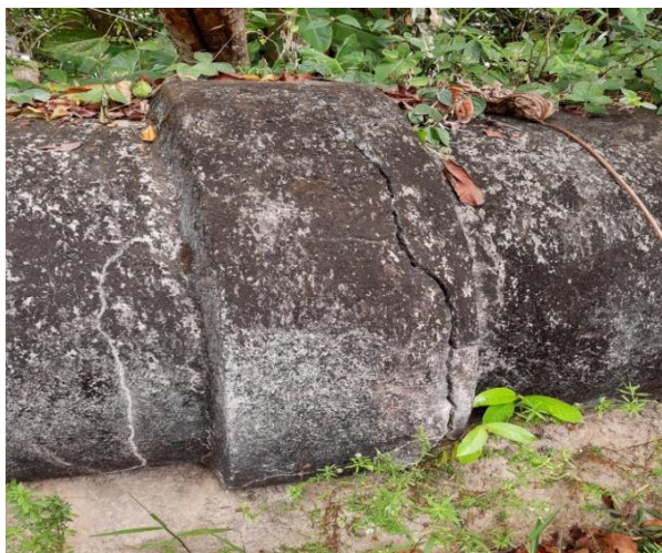
Aqueduto circular Catolé – Cardoso: tubos danificados, presença de rachaduras e vazamentos contínuos.
