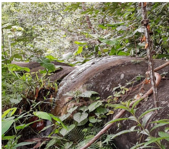
Aqueduto circular Catolé – Cardoso: tubos danificados, presença de rachaduras e vazamentos contínuos.
