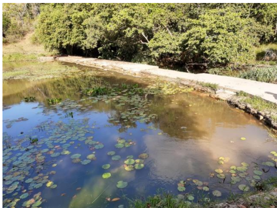
Barramento da Captação Pratagy: excesso de vegetação aquática e deterioração do Barramento executado de maneira inadequada.
