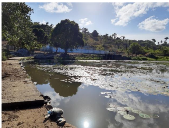
Barramento da Captação Pratagy: excesso de vegetação aquática e deterioração do Barramento executado de maneira inadequada.
