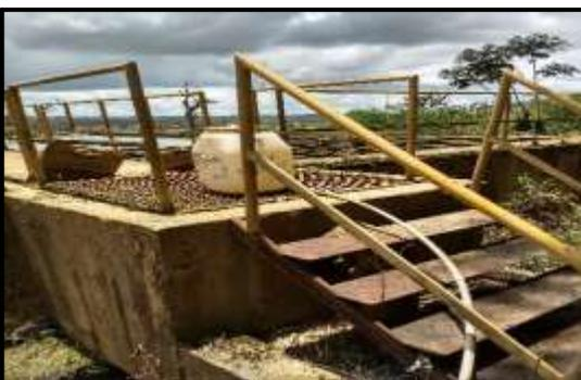
Imagem 02: caixa de distribuição, coagulação e decantação
