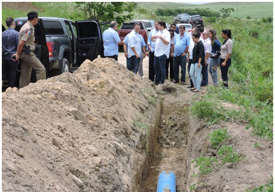
Acompanhado por autoridades, governador assina ordem de serviço para obra em Messias; após assinatura, eles visitaram o local da instalação da nova adutora
