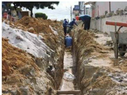
Obras de implantação de rede no Farol
