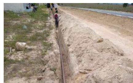
Implantação de rede em Monteirópolis
