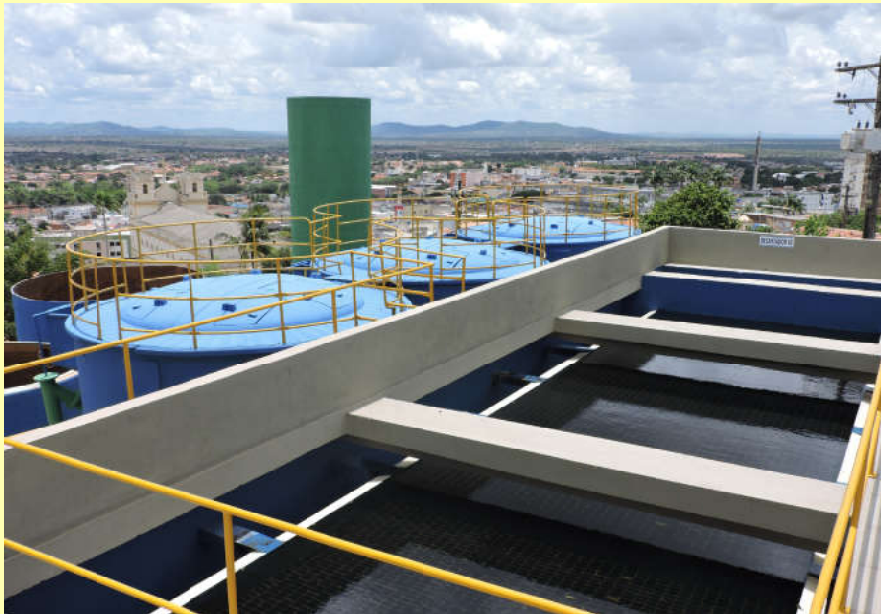
ETA de Palmeira dos Índios foi reformada com recursos próprios da Companhia
