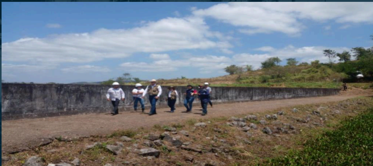
Foto: Acompanhamento da visita técnica da equipe do Projeto Barragem Segura do MPE/AL, juntamente com SEMARH (acervo Casal)
