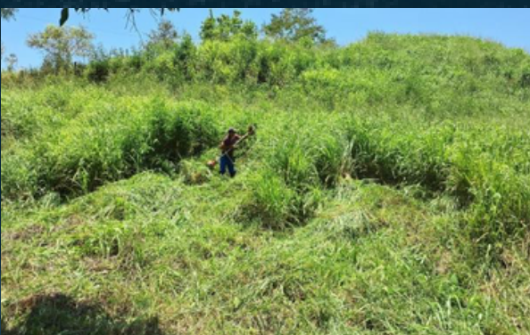
Foto: Roçagem do talude jusante e ombreira direita (acervo Casal)
