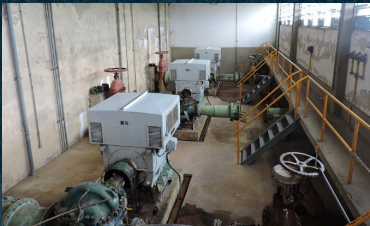
Foto: Conjuntos eletromecânicos das estações elevatórias (Bacia Leiteira) após manutenção preditiva (arquivo Casal)
