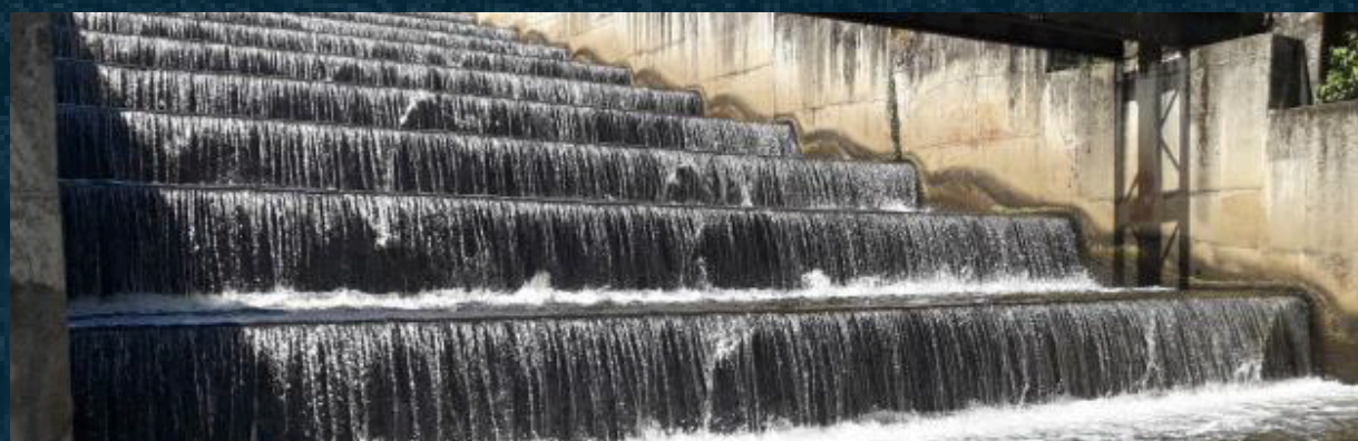
Foto: Barragem Caçamba (acervo Casal)
