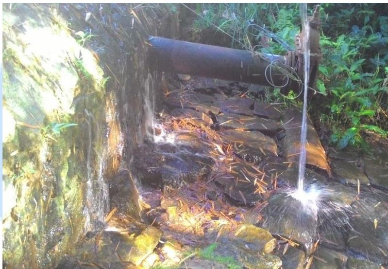
**Figura 2- Vazamentos presentes na barragem.**
