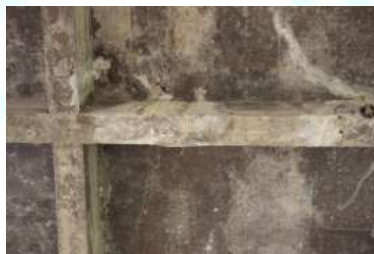
Figura 5. Armadura exposta nas vigas
