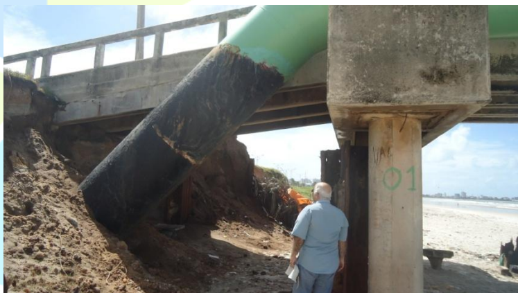
Figura 1 Trecho com o aterro de proteção erodido.
