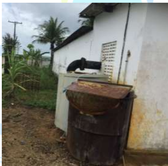
Figura 4 - Tanques descobertos ao lado da parede da casa de bombas.
