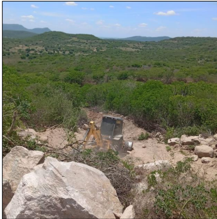
Figura 1. Serviço de engenharia com retroescavadeira FONTE: Arquivo pessoal
