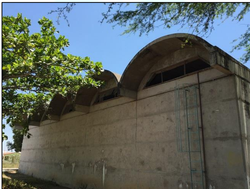
Figura 7 - Telas dos reservatórios rasgadas.
