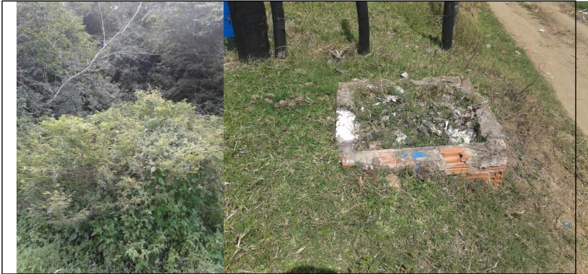
Figura 4 – Trechos apresentando excesso de vegetação sobre a tubulação e dentro das caixas de inspeção.
