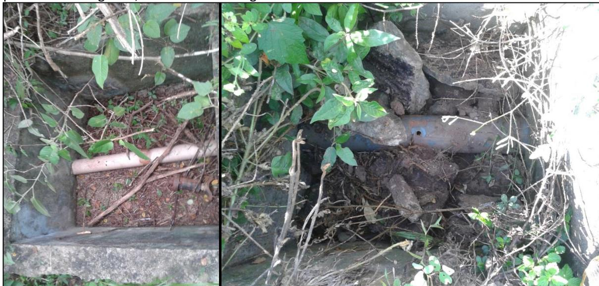
Figura 3 – Trechos com depreciação de conexões e outras peças.
