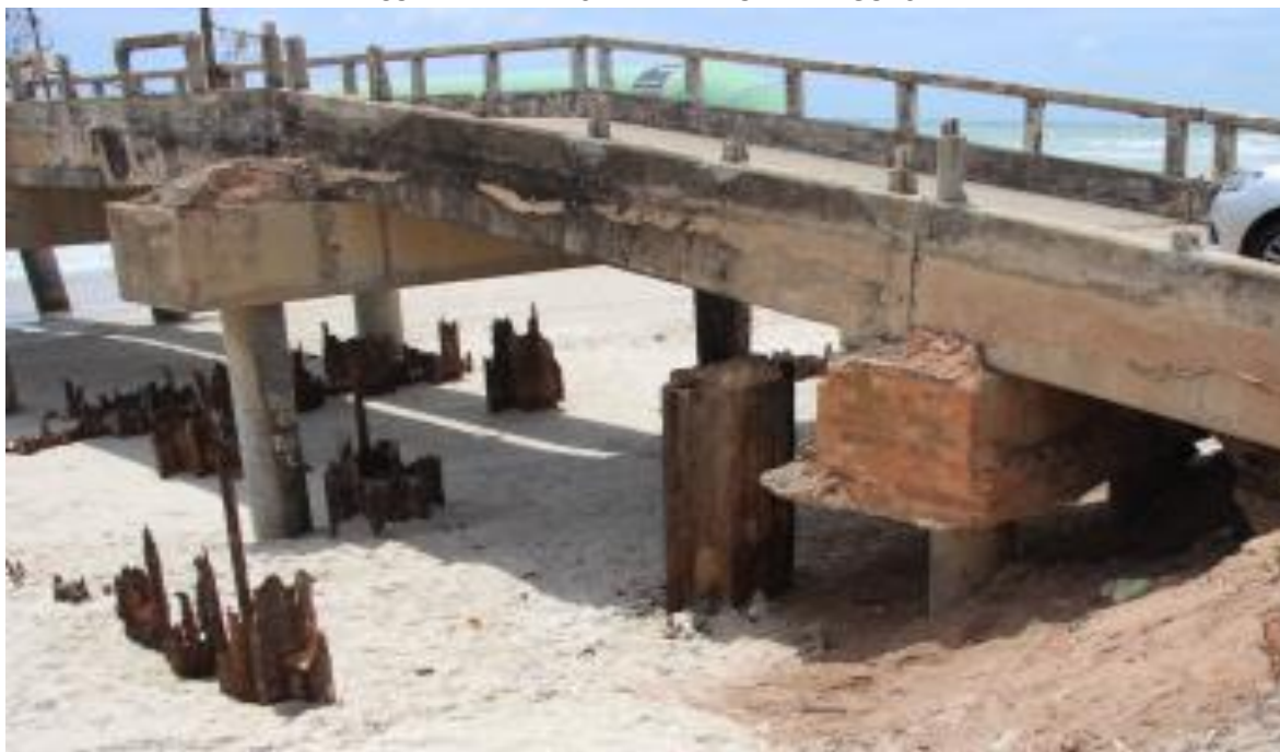
Figura 2 – Vista lateral esquerda do Emissário
