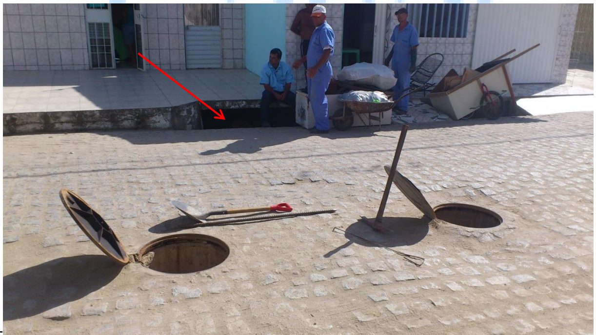
Foto 2. Rua Delmiro Golveia: Galeria por onde passará o interceptor em ferro fundido.
