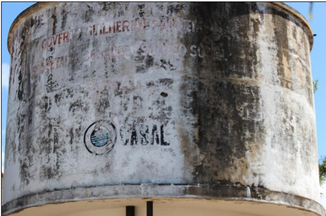
**Figura 3. Indicação de vazamentos na face externa.**
