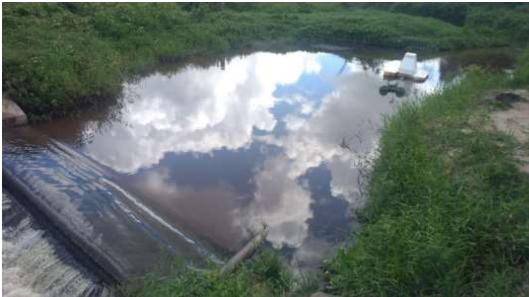
Figura 1 - Atual captação no município de Joaquim Gomes.
