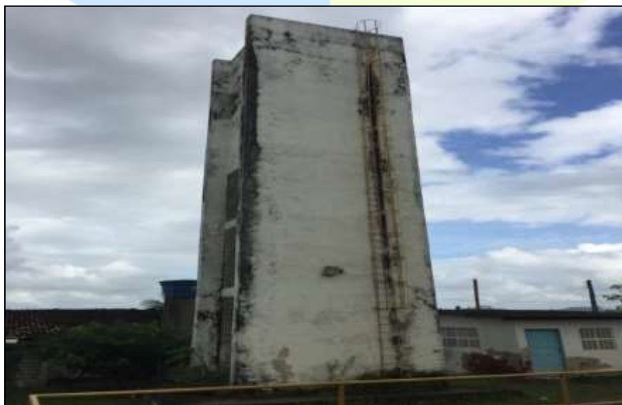
Figura 3 - Reservatório elevado para lavagem dos filtros.
