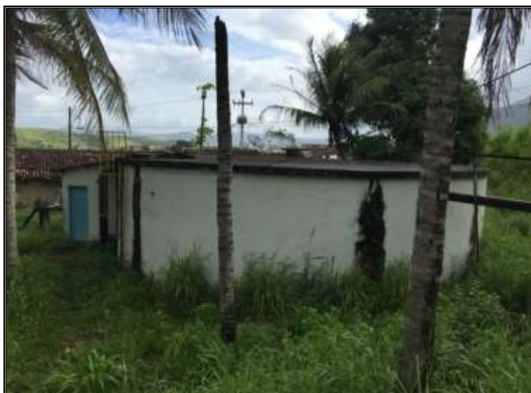
Figura 2 - Reservatório de distribuição.
