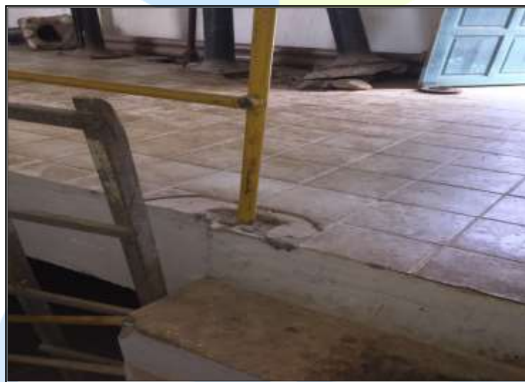
Figura 9 - Escada do prédio da ETA que dá acesso às bombas .
