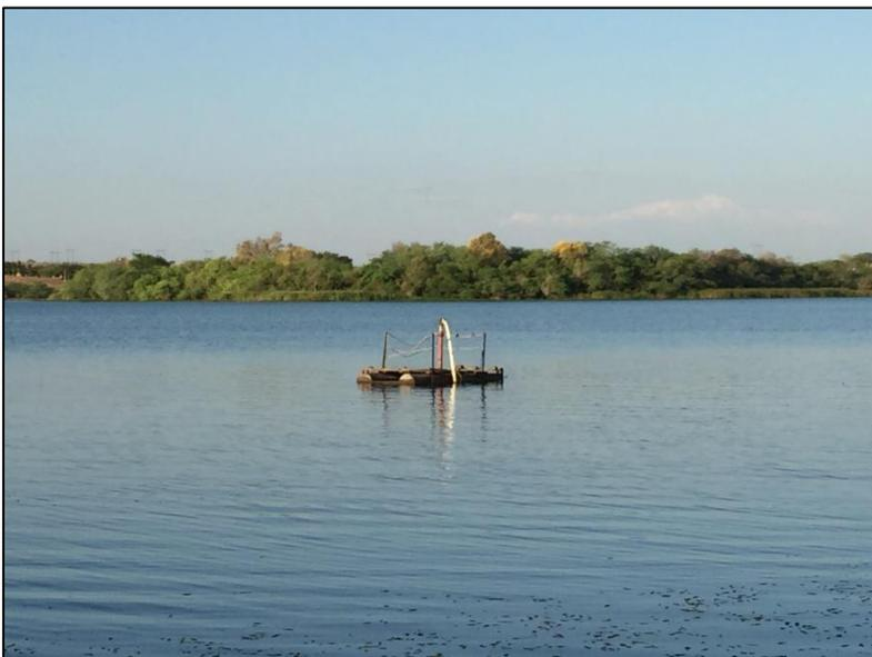
Figura 3 - Captação apoiada em um flutuador.
