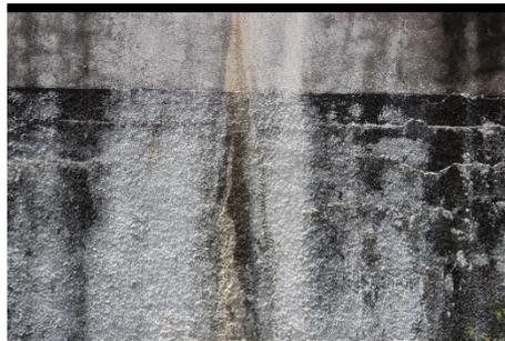
Figura 5. Fissuras na parede do reservatório
