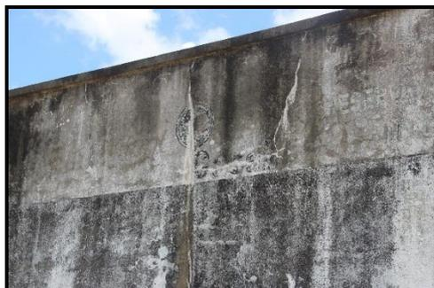
Figura 6. Fissura na parede do reservatório
