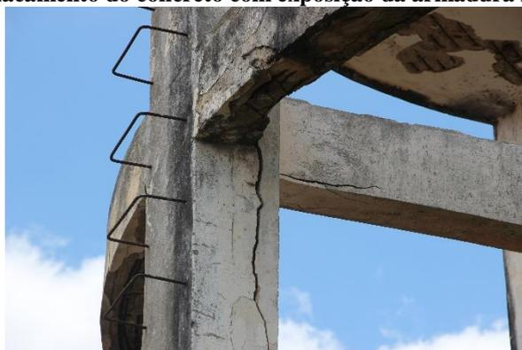
Figura 4- Fissura no pilar e deslocamento do concreto com exposição da armadura na viga
