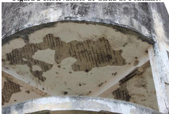
Figura 3-Desplacamento do concreto com exposição da armadura na laje de fundo
