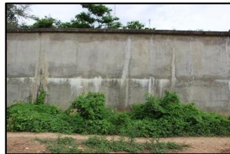
Figura 6. Vazamentos nas juntas de concretagem
