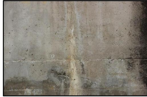
Figura 4. Fissuras na parede do reservatório
