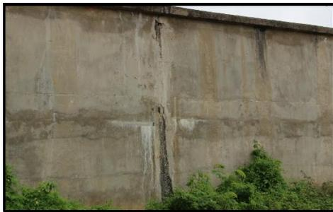
Figura 5. Trincas do concreto na parede.
