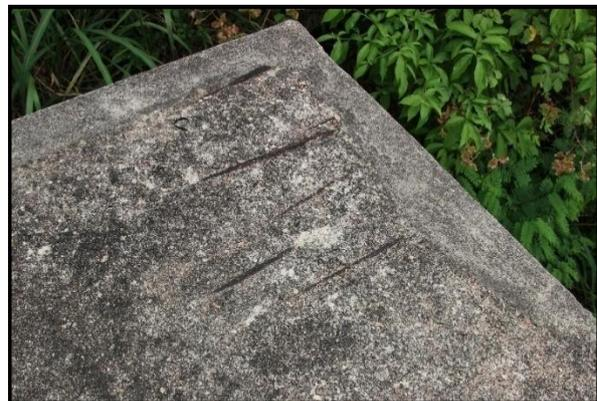
Figura 8. Recobrimento insuficiente da armadura na laje
