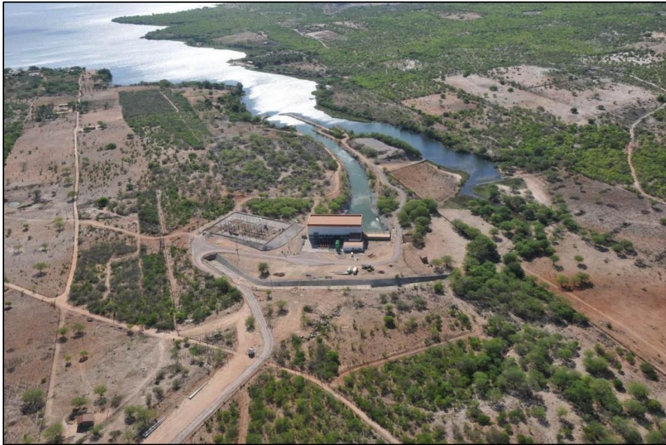
Figura 1 – Vista da captação do Canal do Sertão Alagoano
