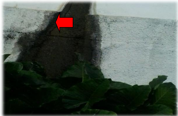
figura 3 Fissura existente
