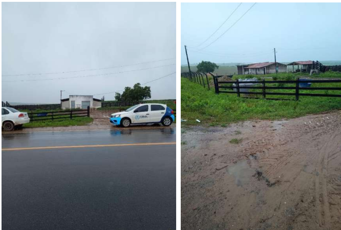
Figura 3 - Local da interligação onde a adutora de 400mm em FoFo cruza a rodovia
